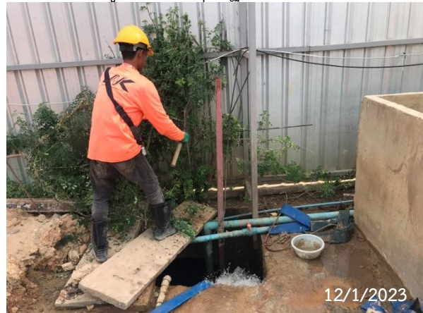
รูปที่ 2-37 การขุดลอกตะกอนดินบริเวณบ่อพักตะกอนดิน
