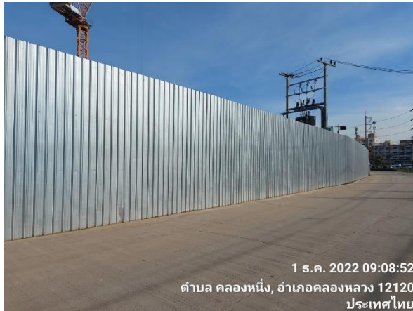
รูปที่ 2-1 รั้ว Metal Sheet ความสูงขนาด 4 เมตร รอบแนวเขตพื้นที่โครงการ
