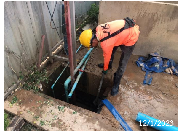
รูปที่ 2-37 การขุดลอกตะกอนดินบริเวณบ่อพักตะกอนดิน
