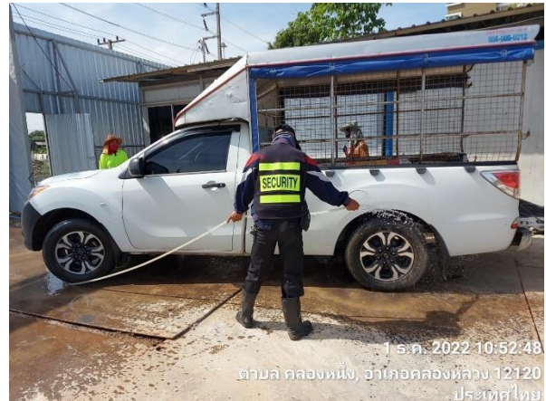
รูปที่ 2-10 การทำความสะอาดดินออกจากล้อรถ
