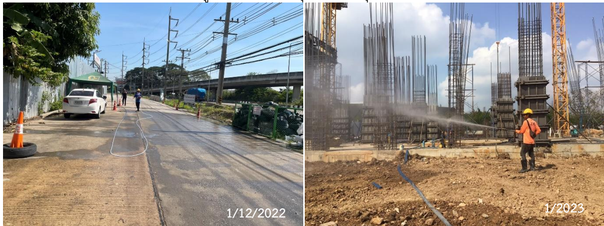
รูปที่ 2-6 การฉีดพรมน้ำบริเวณพื้นที่ก่อสร้างหรือบริเวณที่ทำให้เกิดฝุ่น
