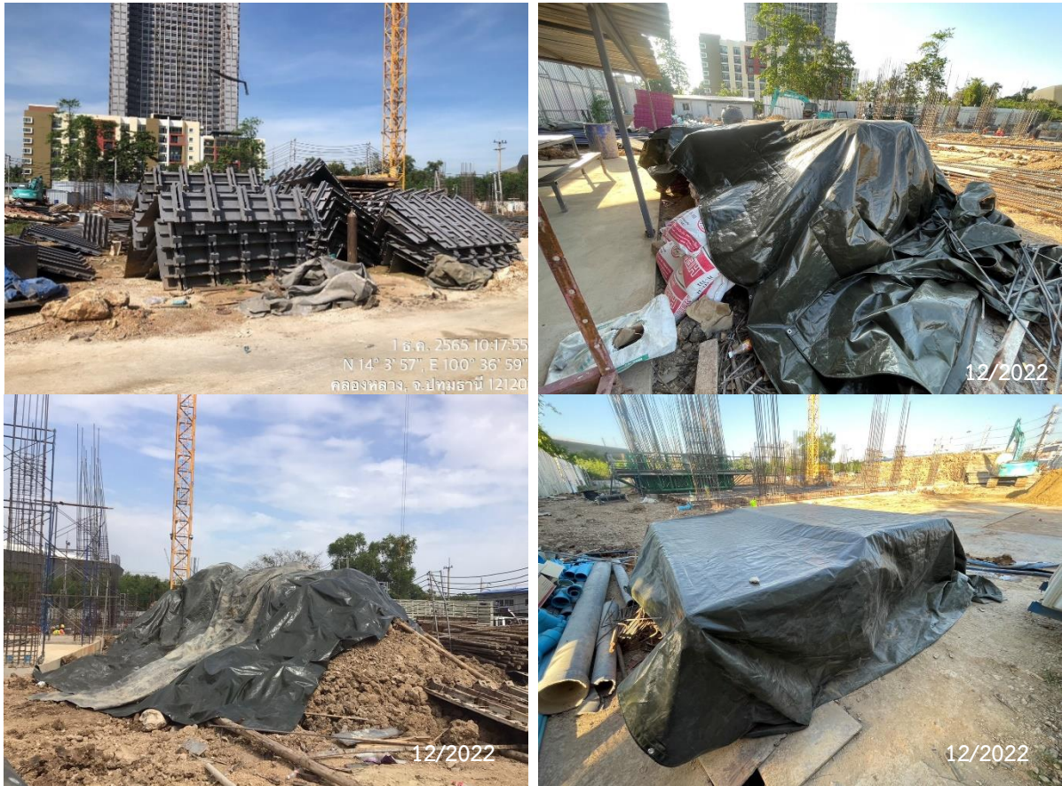
รูปที่ 2-7 การจัดกองวัสดุในพื้นที่โครงการ
