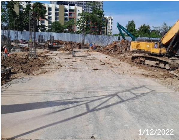
รูปที่ 2-11 แผ่นเหล็กปูรอบบริเวณพื้นที่ก่อสร้าง
